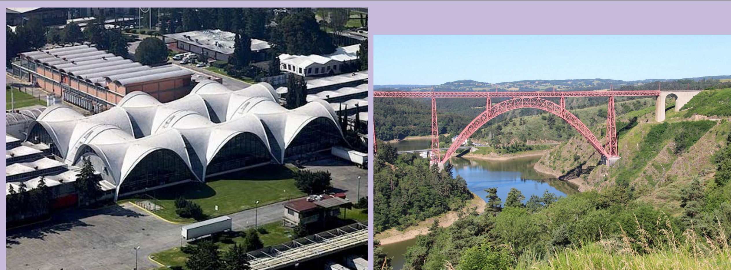
Figure 2. Planta embotelladora de Bacardí en Mexico y Viaducto de Garabit
