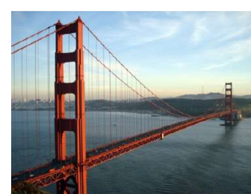
Puentes colgantes: Golden Gate (San Francisco, EEUU)
