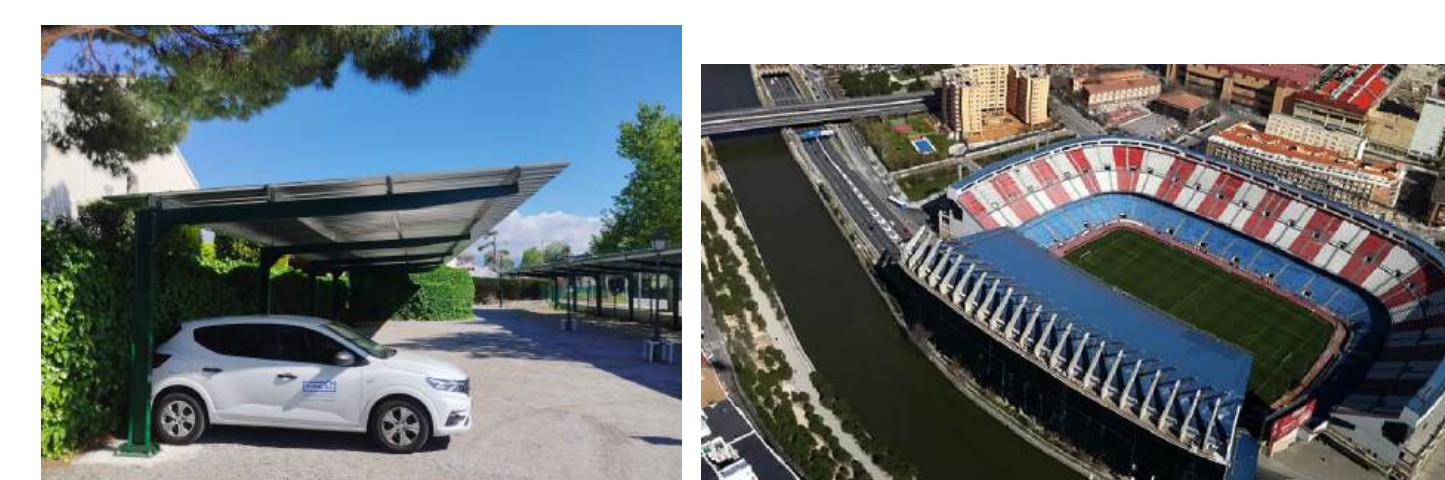
Figure 5. Cubierta de un aparcamiento ( izquierda) y Cubierta del Estadio Vicente Calderón (derecha)
